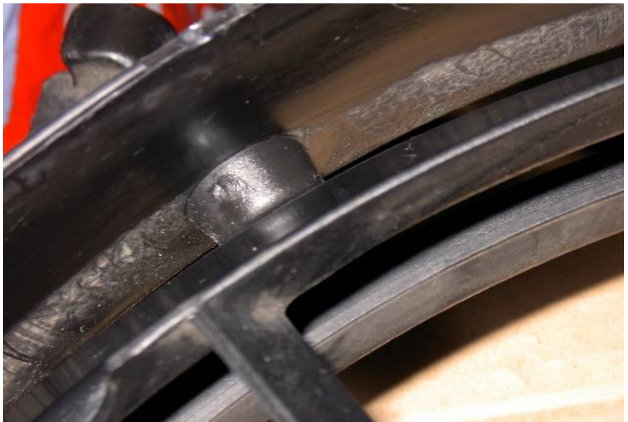
Der schwarze Distanz-Kunststoffpömpel zwischen Zarge und Lüfter
